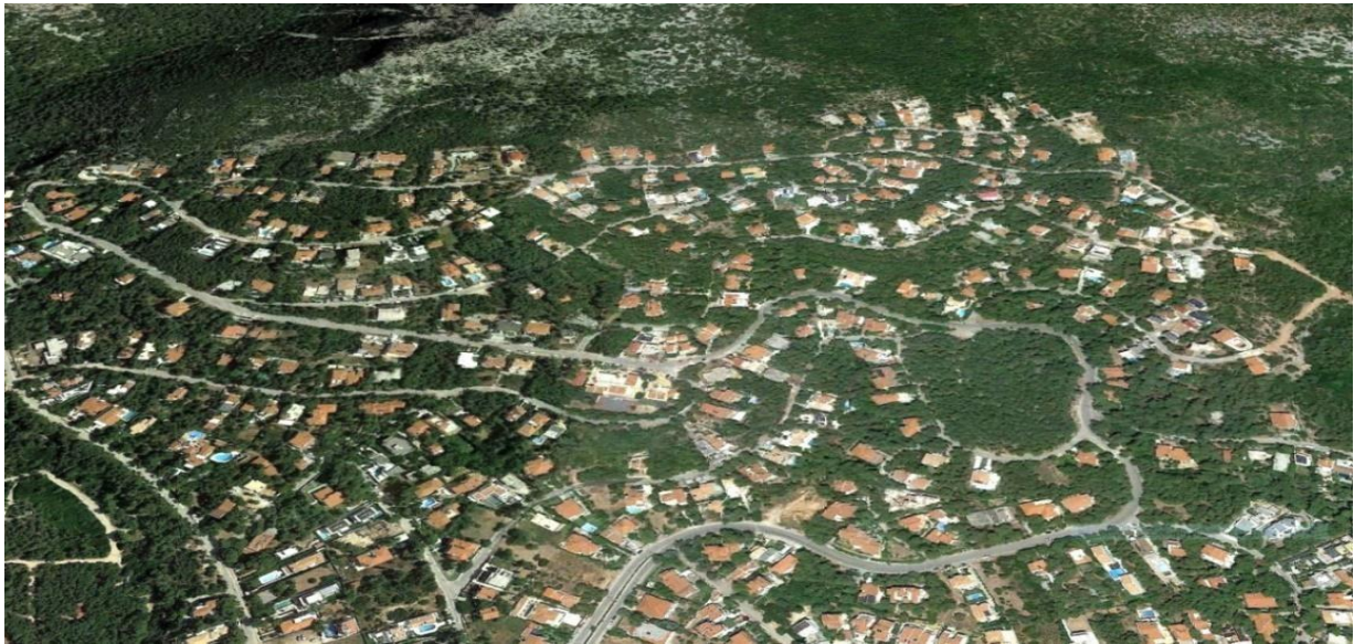
Εικόνα 2. Δομημένη περιοχή που κατά το παρελθόν έχει αναπτυχθεί εντός δάσους ή δασικής έκτασης και τα κτίσματα που την συγκροτούν έχουν μεγάλη εγγύτητα με καύσιμα δασικής προέλευσης
